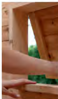
Ouverture dans paroi en bois
