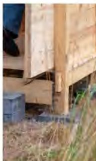
Sol en platelage bois sur pilotis
