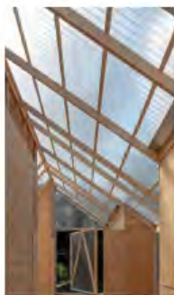
Toiture en tôle ondulée transparente
