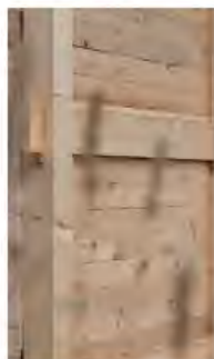
Structure paroi en bois
