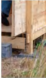
Sol en plateiage bois sur pilotis
