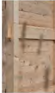
Structure paroi en bois
