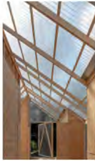
Toiture en tôle ondulée transparente
