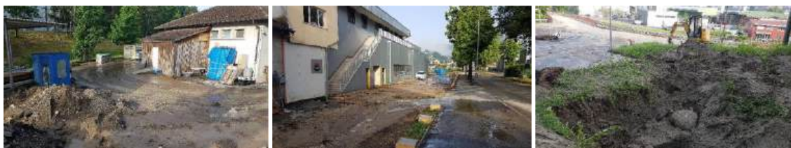
Figure 5: photos de l'inondation du ruisseau de la Brasserie du 17.06.2021
