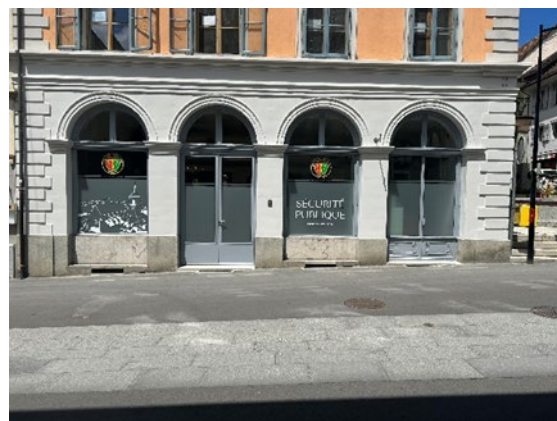
Les nouveaux locaux de la Sécurité publique © Moudon
