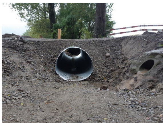
Travaux de réfection du passage @ Moudon
