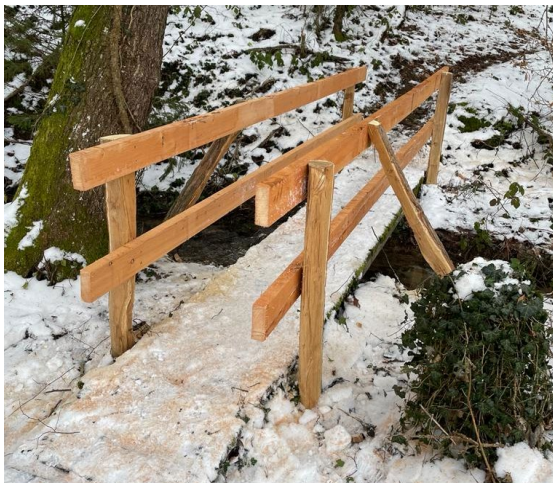
Passerelle au bois des Tavernes @ Moudon
