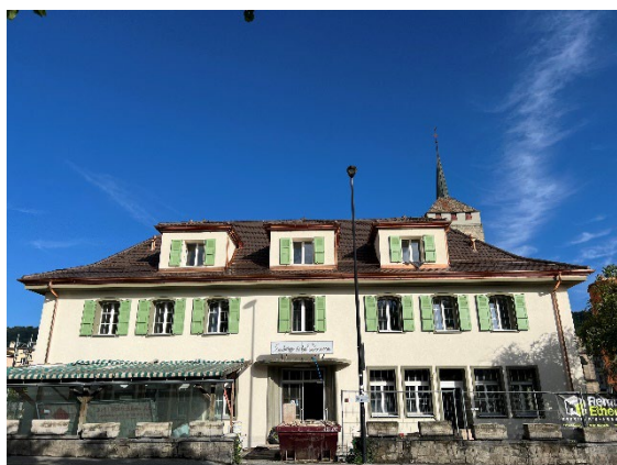
L'auberge communale après la rénovation © Moudon
