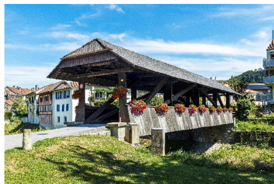
Pont de la Broye © Moudon
