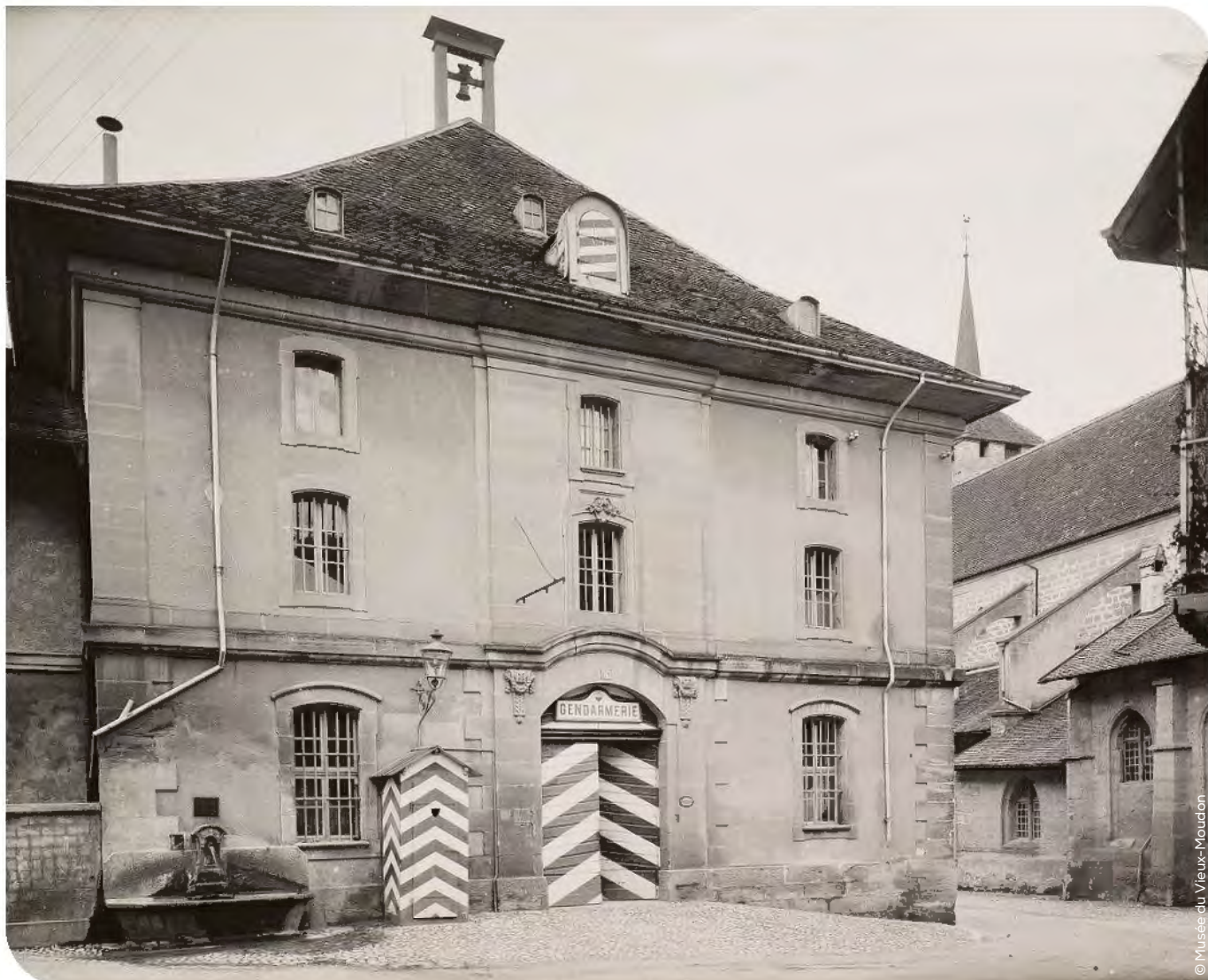
Le grenier bernois de 1773, devenu au XIX e siècle arsenal (construction des deux ailes) et gendarmerie, puis caserne (état vers 1900)
