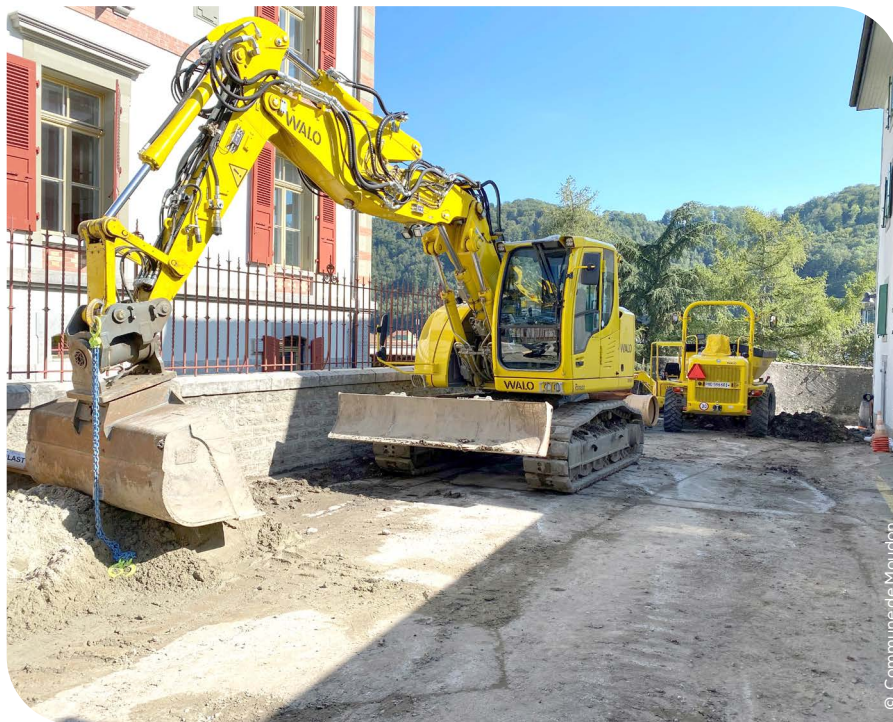
Travaux à la ruelle de la Tour d'Enfer
