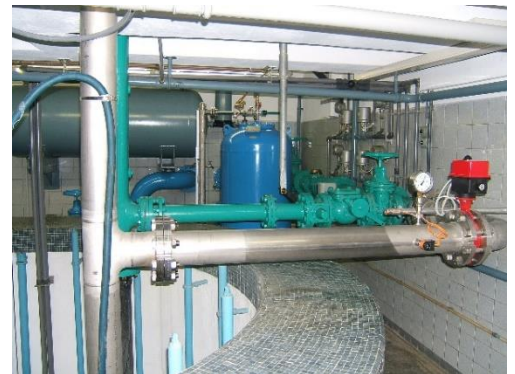
Figure 2 Les conduites plongeantes dans le puits (Les récentes en INOX sont pour la pompe N° 5)
