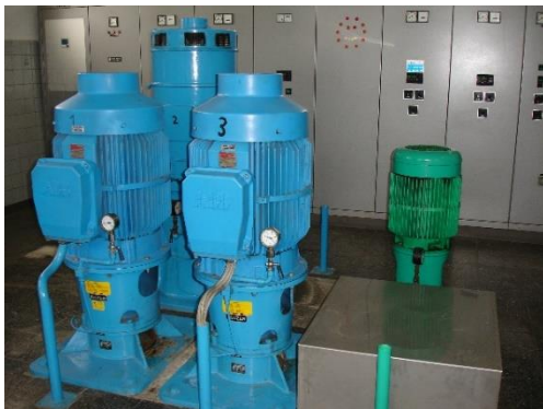
Figure 1 Les pompes 1, 2, 3 (Réseau BP et 6 (en vert). Le caisson en INOX correspond à la pompe N°5 (Immergée au fond du puits)
