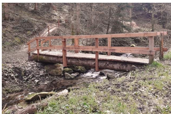
Réalisation d'un pont en bois à La Cerjaulaz sous la conduite du garde forestier © Moudon
