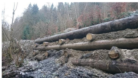
Réalisation caisson en bois © Matthieu Detraz
