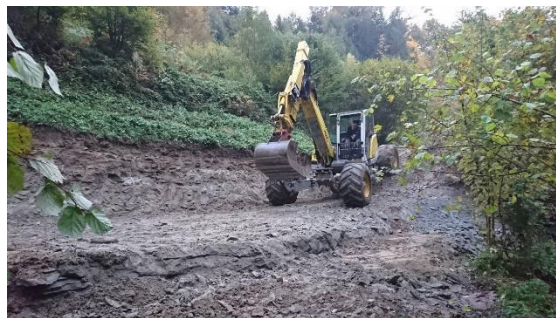
Réalisation caisson en bois © Matthieu Detraz
