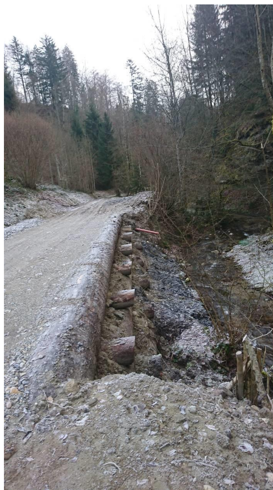
Réalisation caisson en bois © Matthieu Detraz
