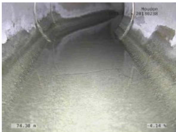
Retenue d'eau ou cuvette
