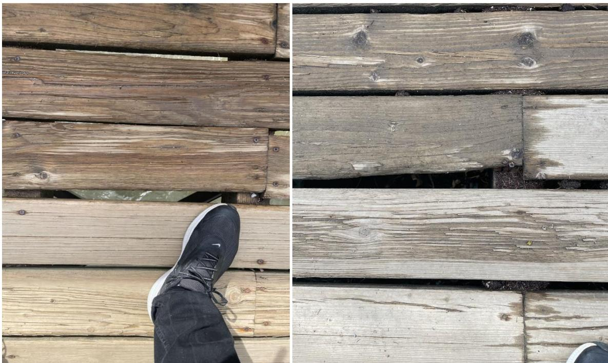
Pour remédier à ces problèmes, le nouveau plancher sera constitué d'une grille en caillebotis et métal déployé galvanisé qui sera recouvert sur une partie de la largeur de la passerelle d'une natte en granules de caoutchouc. Une main courante en inox sera fixée du côté attenant au cheminement recouvert par la natte et les deux rampes métalliques de part et d'autre de la passerelle seront conservées.
