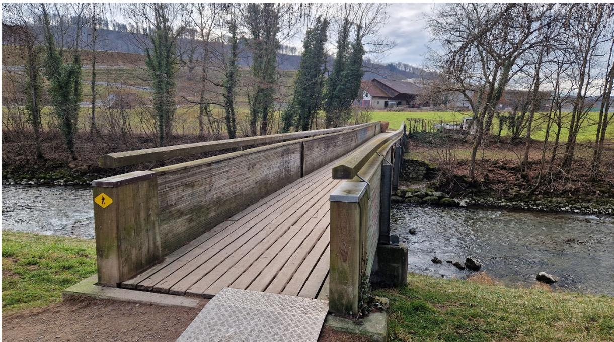
La passerelle est longue de 36.00 m et est posée sur quatre fondations, avec une portée libre de 30.00 m. et une largeur de passage de 2.00 m Elle a été assemblée sur place et chacune des poutrelles est en trois parties.
