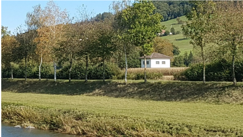
La station de pompage, entre Moudon et Lucens
