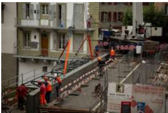
Pose d'une structure métallique © Moudon
