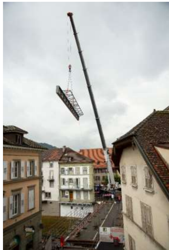
Transport aérien de la structure métallique © Moudon
