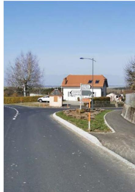
Le passage pour piétons au nord du collège, très fréquenté par les écoliers, est conservé malgré le fait qu'il se situe en zone 30 km/h. Les bordures du trottoir de part et d'autre seront abaissées pour permettre le passage aisé des personnes à mobilité réduite et des poussettes.
