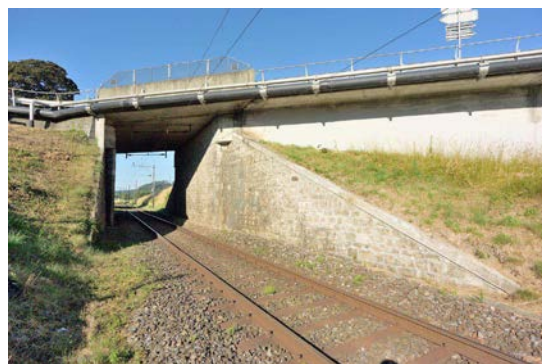
Photo 1 Pont CFF des Sorbiers
