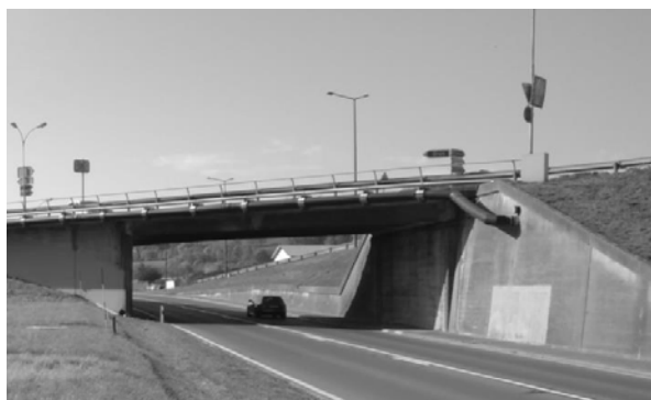
Photo 2 Pont routier des Sorbiers sur le RC 601
